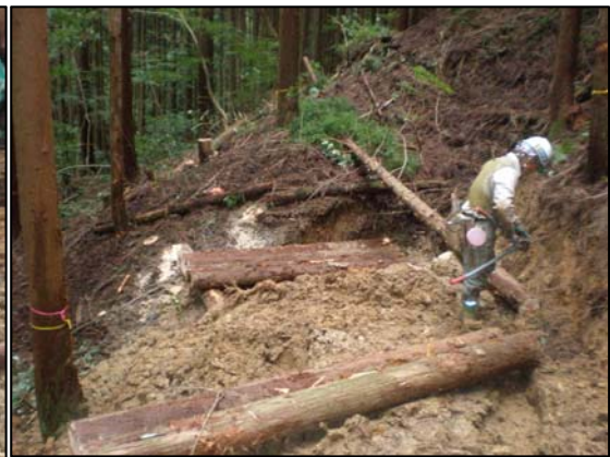
【開設状況（凹み箇所に丸太を埋設）】
