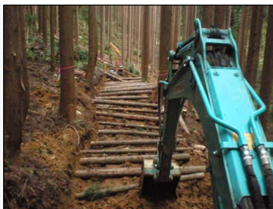
【開設状況（丸太を敷設）】
