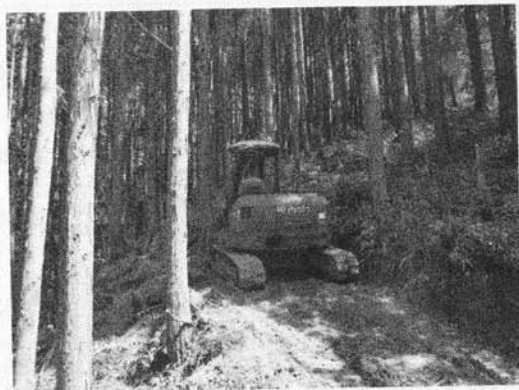
小型バックフォアによる作業路開設
