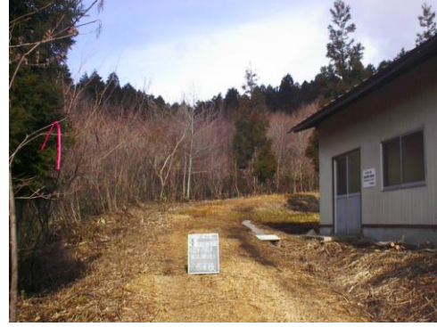
森づくり活動の拠点として活用する作業小屋
