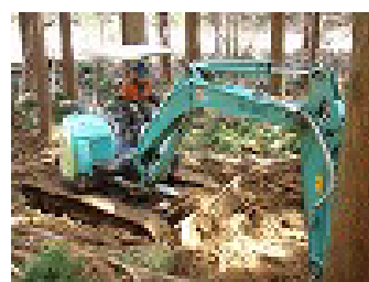
(上) 搬出した材 (中) 開設中の作業道 (下) ユンボで切削する鈴木代表
