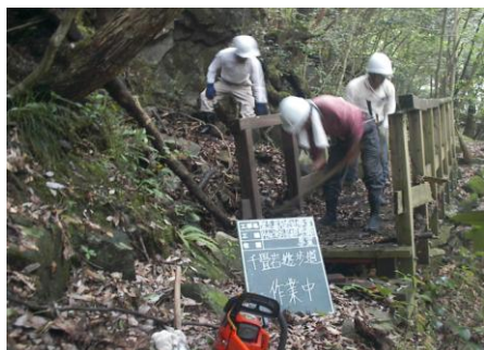
遊歩道の補修作業
