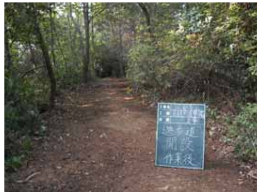
山の尾根部を伐開し、歩道を開設。
