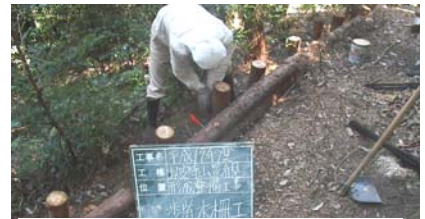
木柵工事中の以安寺山の歩道
